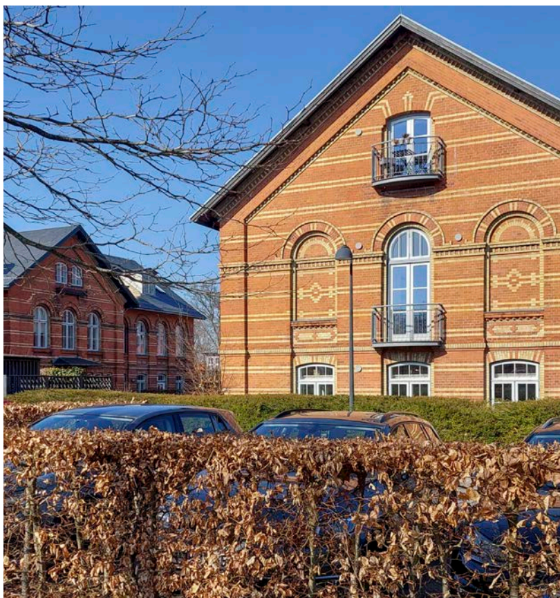
Billede 2.2: Pavilloner i det ældste anlæg, Ebberødgaard
