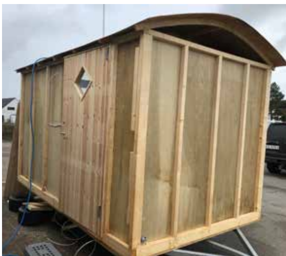
Figur 3: Det mobile badehus – prototype af det mobile badehus under konstruktion. Fotos: Det mobile badehus.
