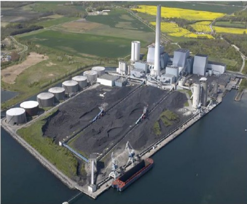
Studstrupværket: 10 % halm tilsatsfyres til kul
