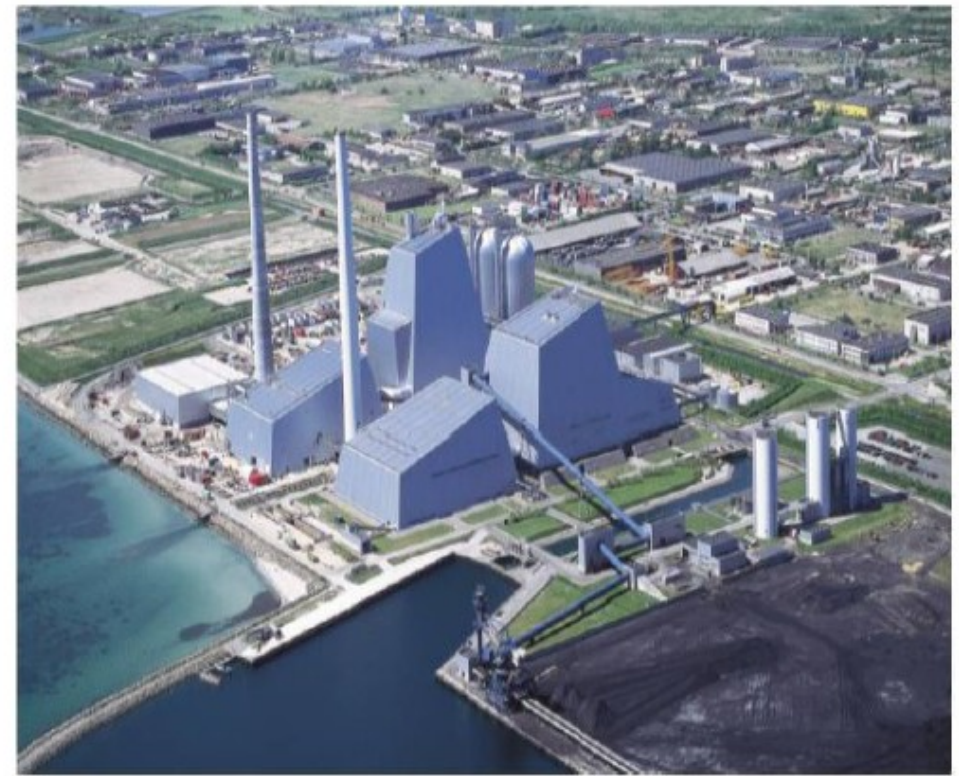
Avedøreværket: 100 % træpiller op til 70 % last
