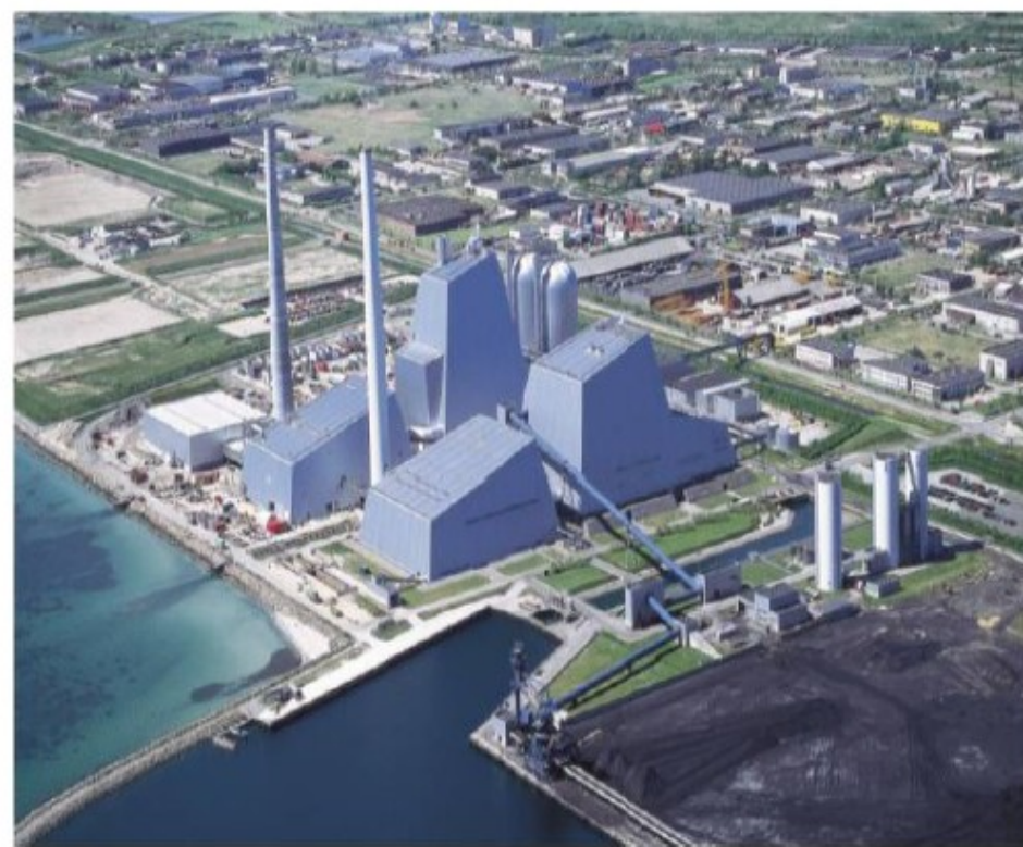
Avedøreværket: 100 % træpiller op til 70 % last
