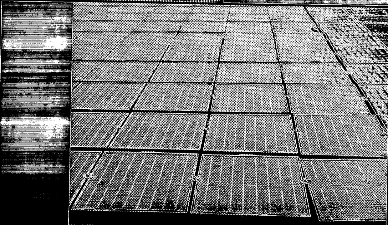
Figur 33. Fota anlæggets fastspænding af solceller, set udefra, med synlige skader.
