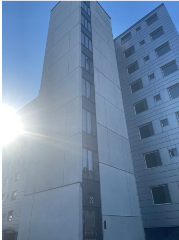
Figur 1 Billede over nyetableret elevatorskakt i Nøjsomhed, som en del af omdannelsesindsatsen i boligområdet. (Taget 20.april 2023)
