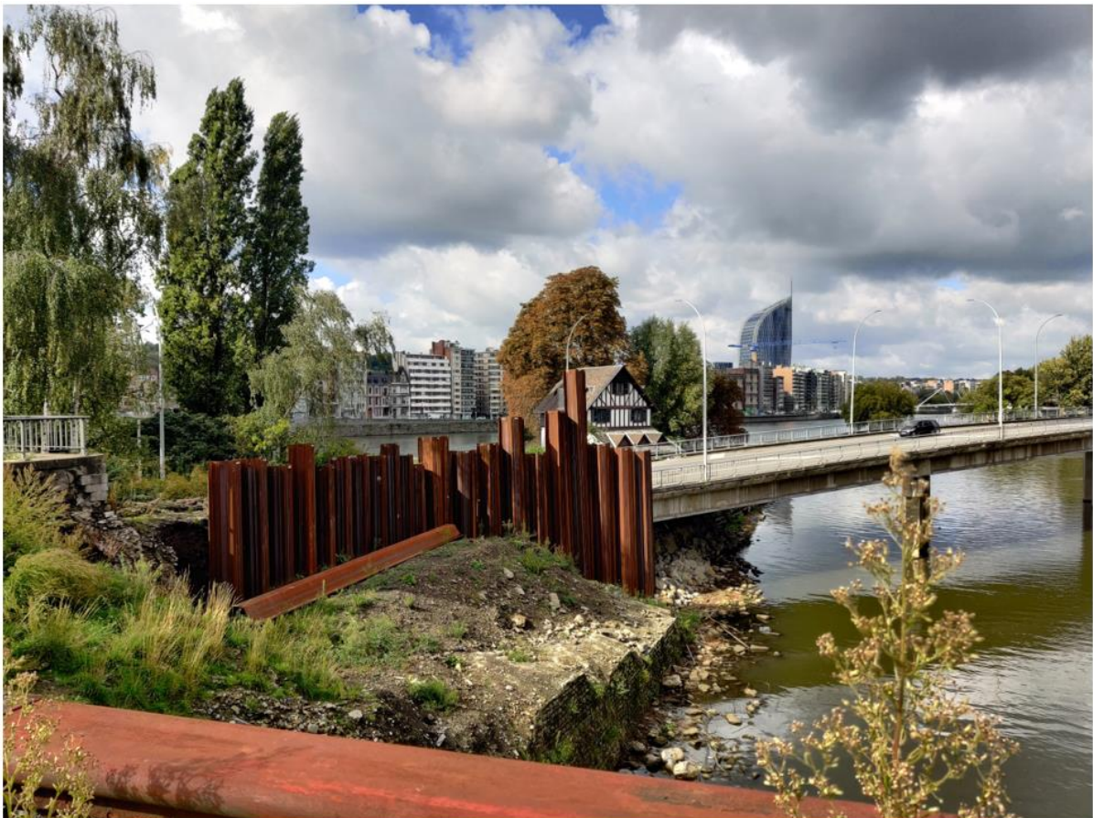
Billede 1: Forstærkning af flodkanten langs Maas floden, Liège (Feltbillede).
