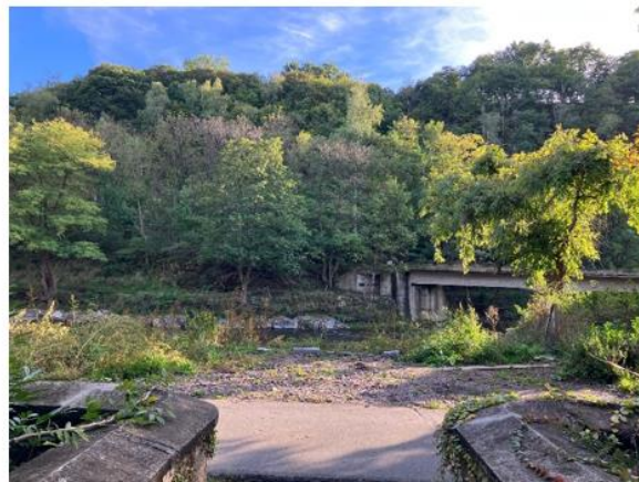
Billede 15, 16 og 17: Rue Au Moulin, Trooz, over tid. Øverst til venstre ses broen en sensommer før oversvømmelserne, øverst til højre ses broen en vinter før oversvømmelserne, nederst i midten ses broen et år efter oversvømmelserne i Trooz (Sarah, bilag 12).
