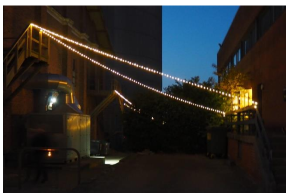
Lysinstallation og lyskæder på Sukkerfabrikkens siloer. På vej mod Jordramperne.
