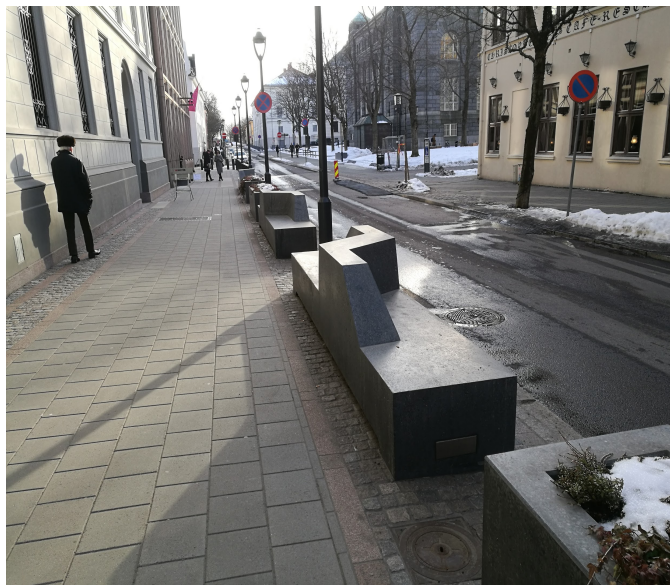
Billede 9: Multifunktionel sikring ved Norges Bank (Bilag 3.1)
