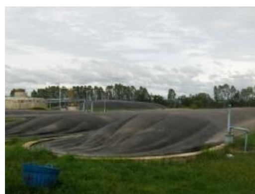
Figur 8: De overdækkede gylletanke hvor metan-gassen opsamles, eget foto
