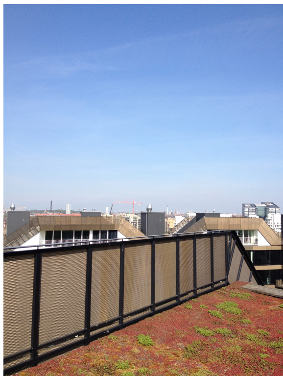
Billede 3: Ekstensivt grønt tag på A-huset og Billede 4: Tagterrassen på A-huset
