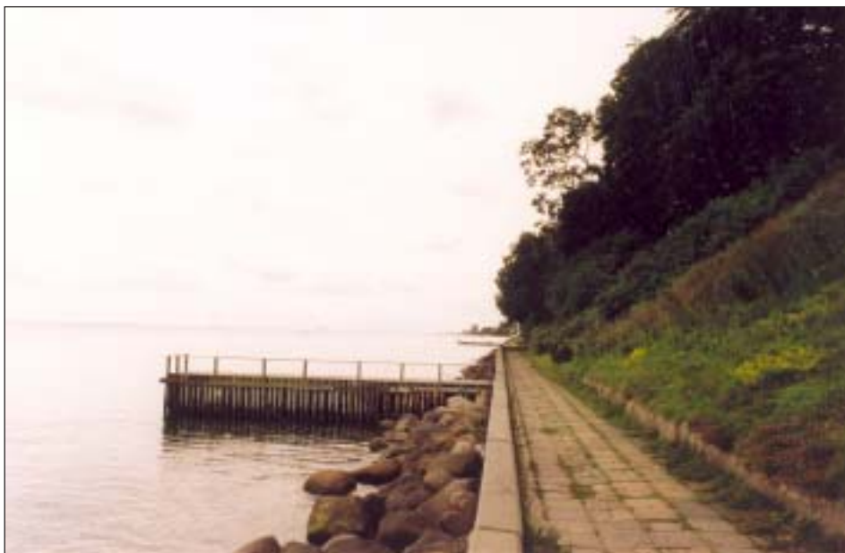
Figur 7: Kysten midt i området med bådebro og strandpromenade i beton. Forf. foto 1998.
