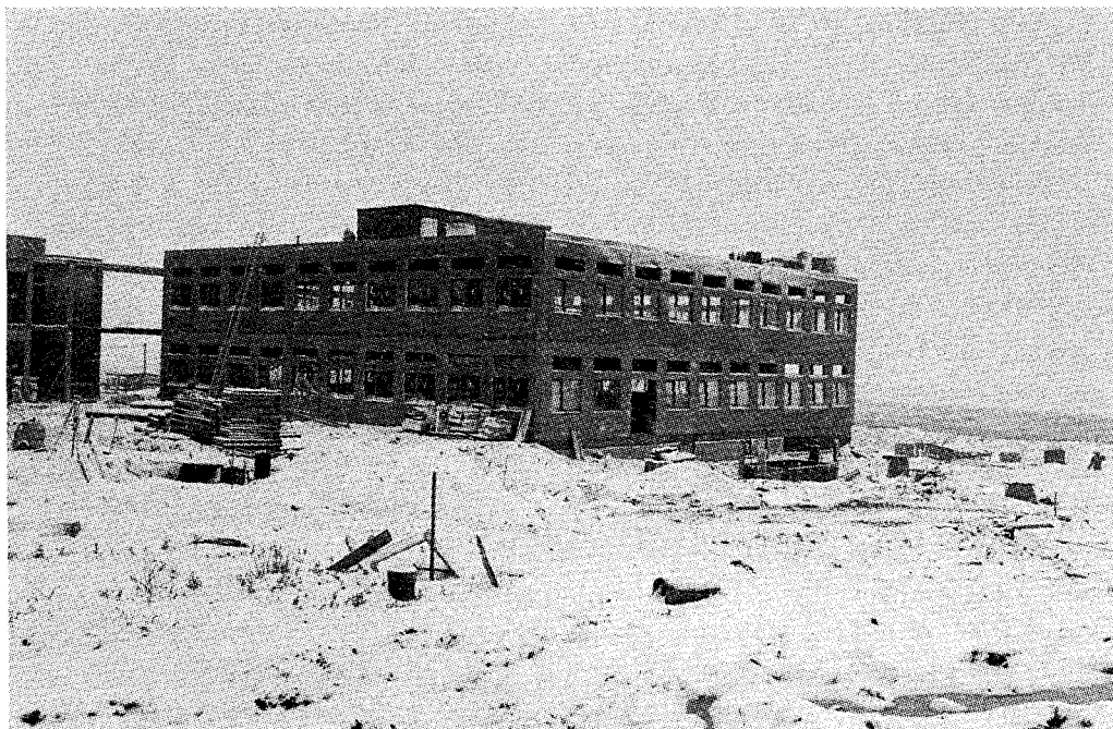
Vinterbyggeri – 1973. I byggeriets 2. etape blev de mindre bygninger, bygning 04, 05 osv. opført. Foto: RUC-NYT.
