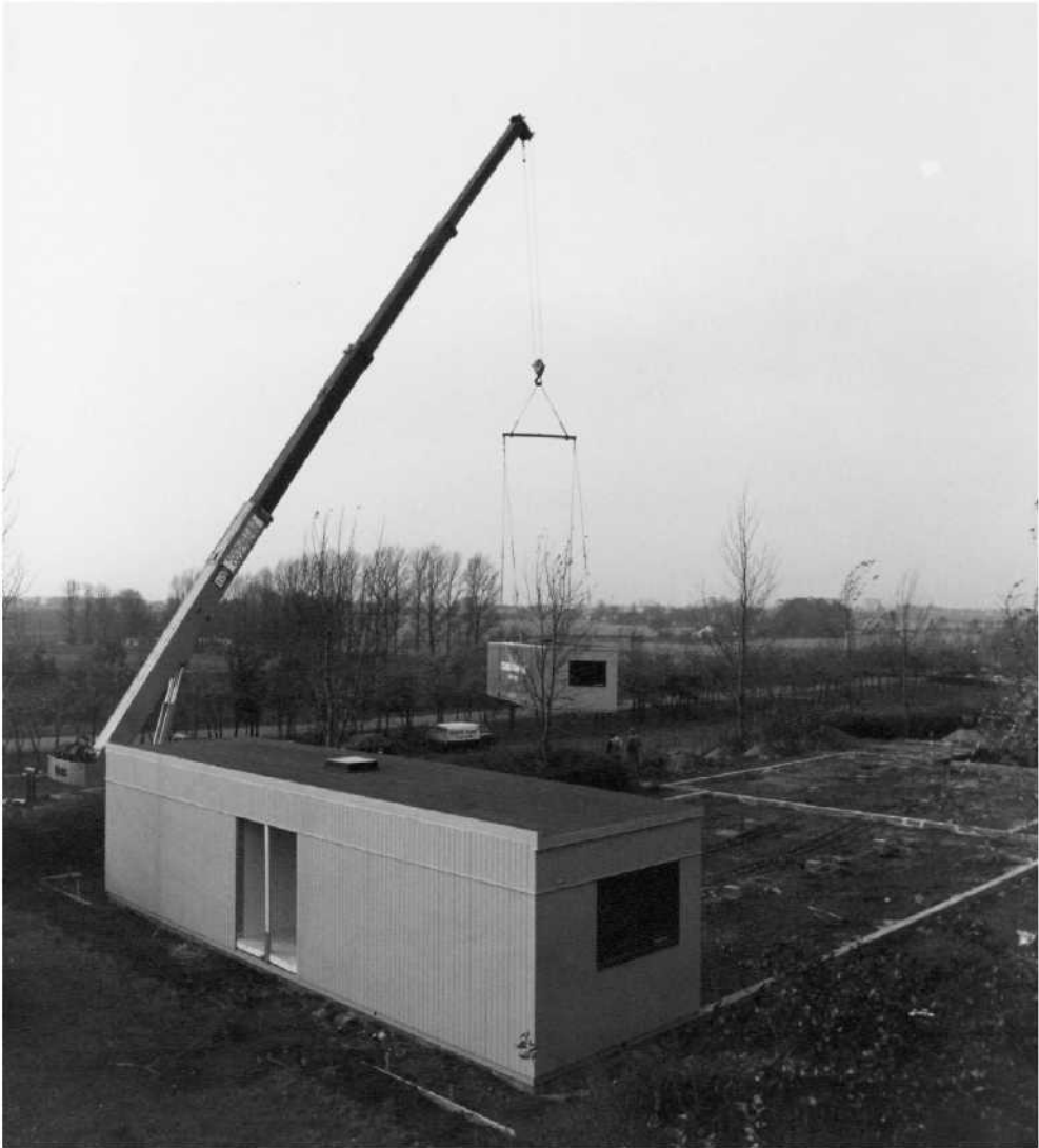
Midlertidig udbygning af RUC, 1987.
