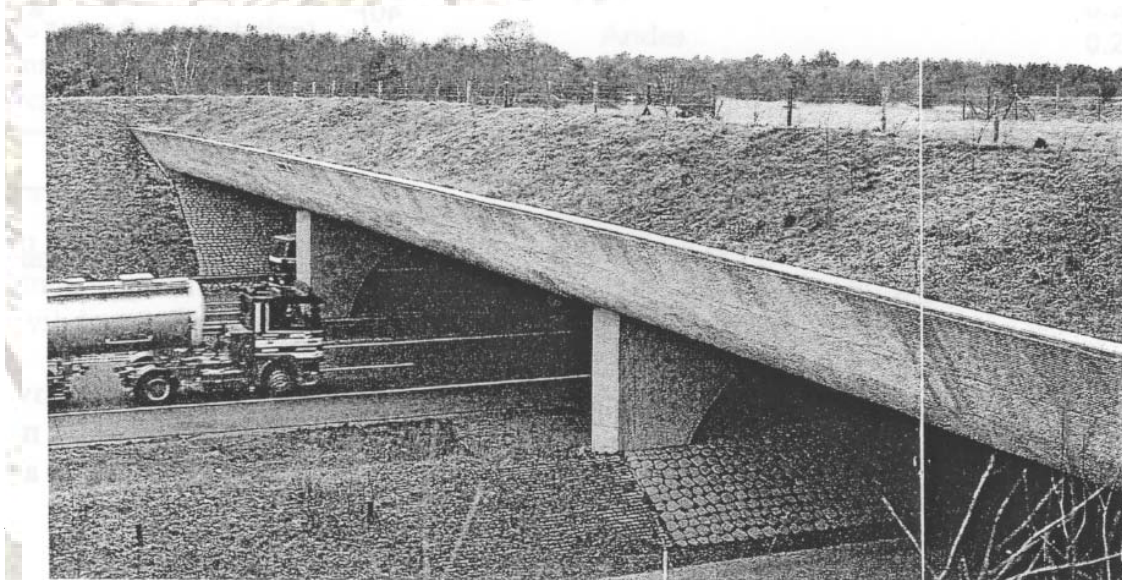
Faunaoverføring som forbinder et gennemskåret naturområde, Holland.
