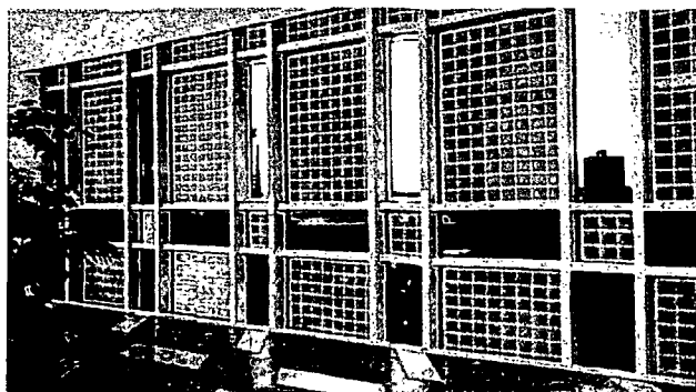
Figur 19. Solcellefacade på kontorbygning i Aachen, set indefra.
