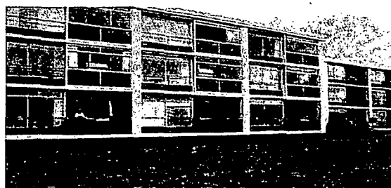
Figur 20. Solceller integreret i altaner (Kolding).
