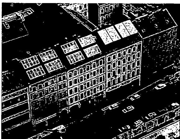
Figur 15. Solceller i etageboliger, Luisenstadt, Tyskland
